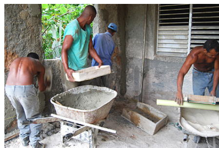
横流しの建築資材が多い
